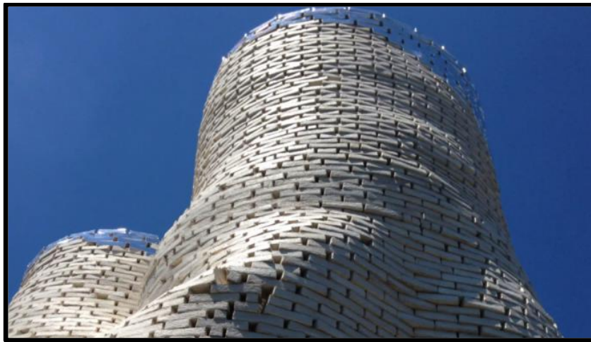
Şekil 5. Miselyum tuğlalardan yapılan ilk büyük ölçekli yapı (URL 4)
